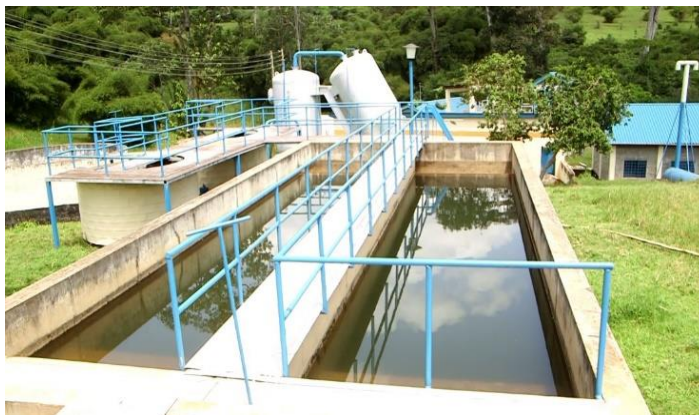
Old plant sedimentazione basin
